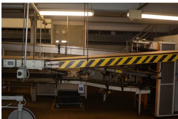
Pareizi iekārtota darba vieta.
