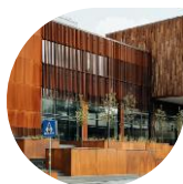
VALMIERAS TEĀTRA ĒKAS ENERGOEFECTIVITĀTES PAAUGSTINĀŠANA
