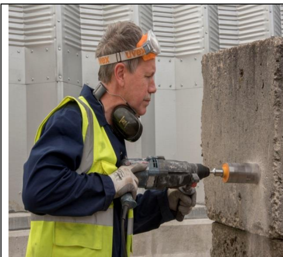
Slikta prakse — rokā turama urbja izmantošana, neveicot atsūkņēšanu un neizmantojot EAL (HSE, Lielbritānija)
