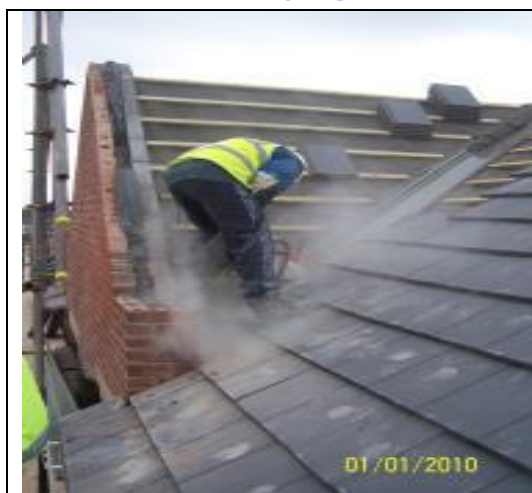
Slikta prakse — jumta dakstiņu griešana bez kontroles pasākumiem ( National Federation of Roofing Contractors Ltd, Lielbritānija )
