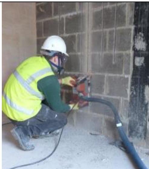
Laba prakse — betona rievošana, veicot atsūkņēšanu no instrumenta (HSE, Lielbritānija)
