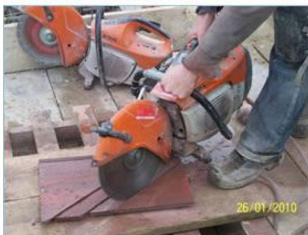
Labā prakse — jumta dakstiņu griešana ar dakstiņu griezēju ( National Federation of Roofing Contractors Ltd, Lielbritānija )
