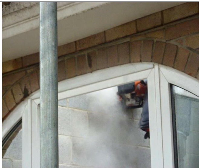
Slihta prakse — betona rievošana, neizmantojot atsūkņēšanu no instrumenta vai EAL (HSE, Lielbritānija)
