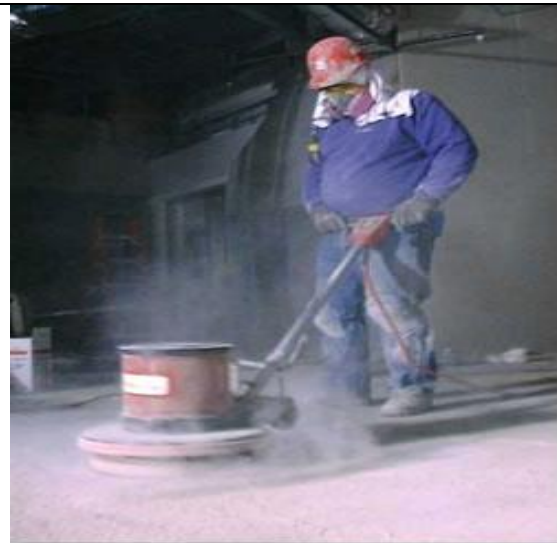
Slikta prakse — betona grīdu slīpēšana, neveicot atsūkņēšanu no instrumenta (GDWW, Beļģija)
