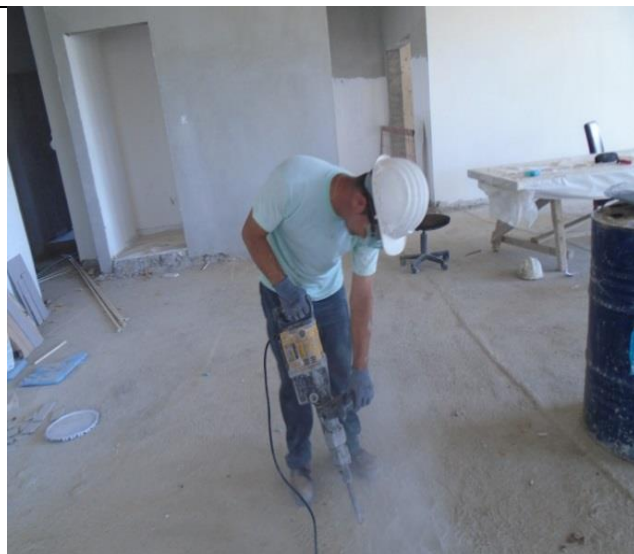
Slikta prakse — rokā turama drupinātāja izmantošana, neveicot atsūkņēšanu no instrumenta (DLI, Kipra)
