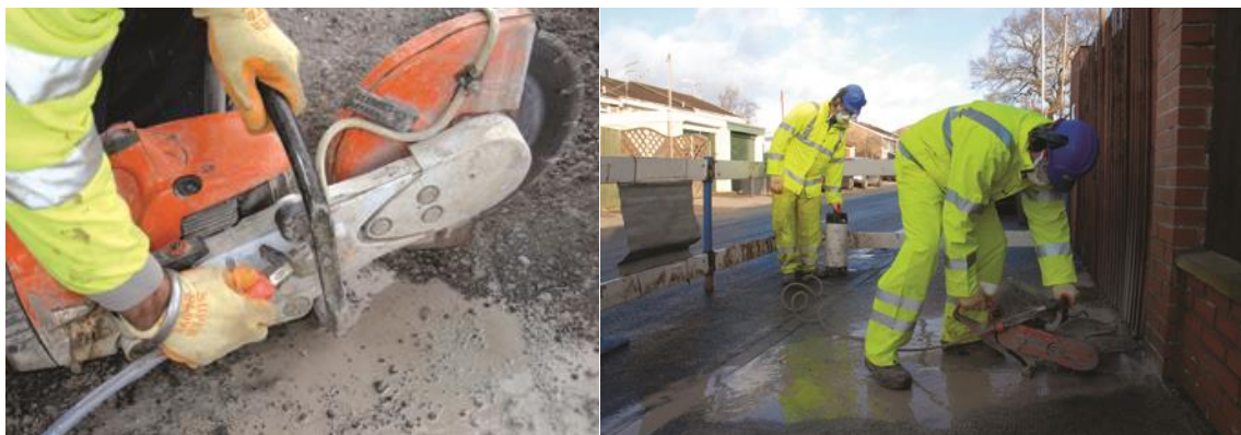
2. attēls. Fotogrāfijās attēlota sistēma slapēšanai ar ūdeni (avots: HSE, Lielbritānija).
