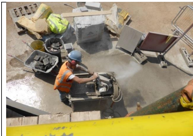
Slikta prakse — slapšana ar ūdeni nenotiek vai tā nav pietiekama, netiek lietoti EAL ( HSE, Lielbritānija )
