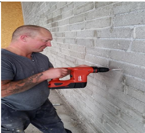
Slikta prakse — rokā turama urbja izmantošana, neveicot atsūkņēšanu no instrumenta (HSE, Īrija)
