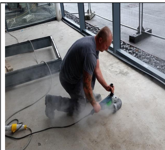
Slikta prakse — rokā turamas slīpmašīnas izmantošana, neveicot atsūkņēšanu no instrumenta (HSA, Īrija)
