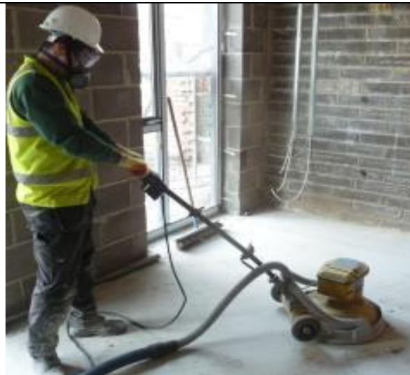
Laba prakse — betona grīdu slīpēšana, veicot atsūkņēšanu no instrumenta (HSE, Lielbritānija)
