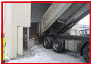
Gājēju pārvietošanās ceļi tiešā smagās tehnikas darbības zonā var būt smagu nelaimes gadījumu iemesls
