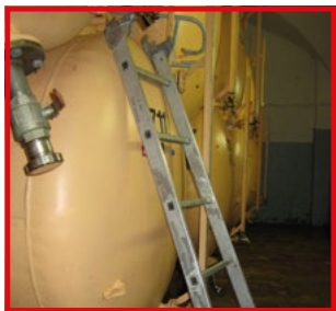
Pārvietojamo kāpņu izmantošana piekļuvei pie iekārtas un tās tīrīšanai rada augstāku nelaimes gadījumu risku
