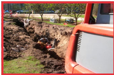
Darba veikšana tranšējās, kurām nav nostiprinātas sienas, var beigties ar letējiem nelaimes gadījumiem
