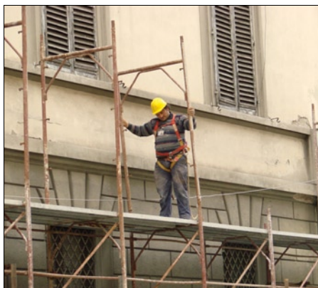
Pareizi veikta sastatņu montāža notiek secīgi katrā sastatņu līmenī
