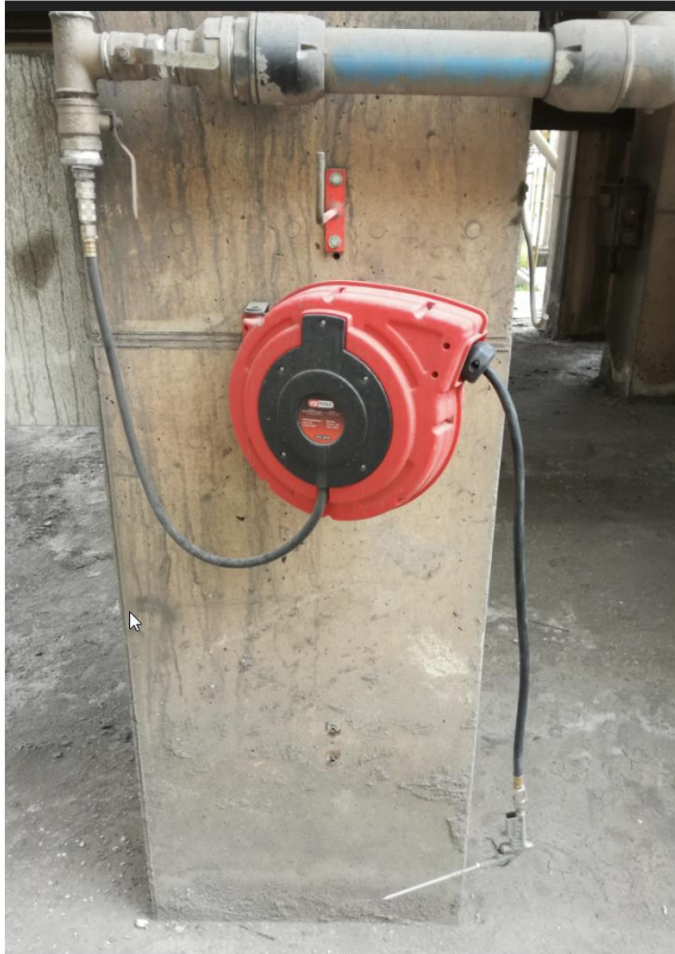
Saspiestā gaisa caurule: agrāk mētājās pa zemi un ķērās darbiniekiem kājās. Tagad automātiski sarullējas spolē
