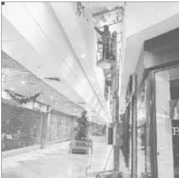
Priekšlikums 4: Čīstēnī sklenēnų atrīī a sīrēch zevnītr̄ za pomoci pojīzdnē zdvihací pracovní plošiny s výložníkem
