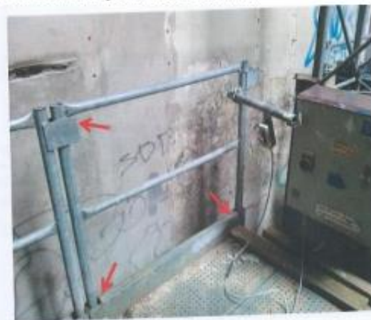
4. Fototēls. Platformas MA1200 margu posms, kas bija izņemts maisu izkraušanas darbība laikā, kad platforma atradās 5. stāva logu ailes līmenī. Margu posms ir viegli noņemams pēc vajadzības.
