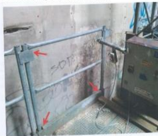
4. Fototēls. Platformas MA1200 margu posms, kas bija izņemts maisu izkraušanas darbība laikā, kad platforma atradās 5. stāva loga ailē. Margu posms ir viegli noņemams pēc vajadzības.
