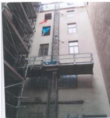
1. Skatoties. Platforma MA1200 ar reģistrāciju Nr. 20100079. Ar kāju, kas atrodas loga ailē 5. stāvā, pa kuru notiek nogāzums laikā tika veikta apmetuma darbi.
