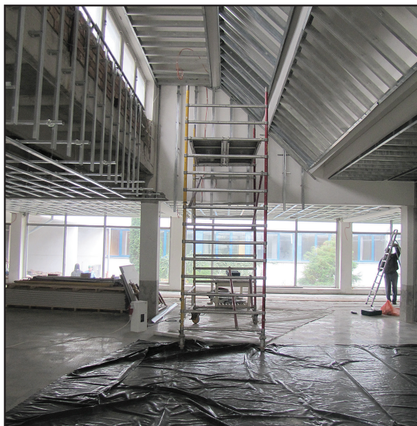
Pārvietojamo sastatņu lietošana ir drošs un efektīvs piekļuves veids dažādām būvdarbu zonām
