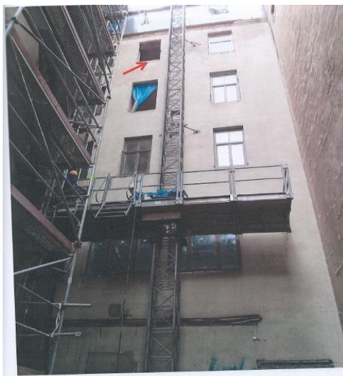
1. fotoattēls. Pacelāja MA 1200 ar reģistrācijas Nr. 2CP020579. Ar bultu norādīta loga aile 5. Stāvā, pa kuru nelaimes gadījuma laikā tika iekrauti apmetuma maisi.
