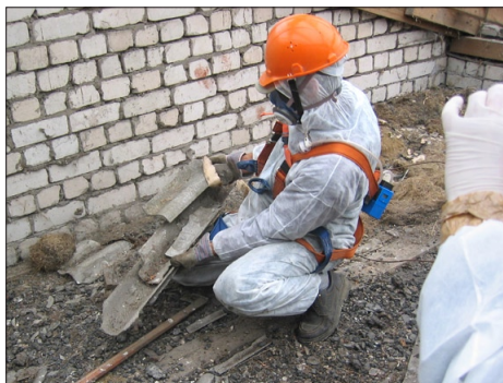
Azbesta šķiedru paraugu ņemšana darbu veikšanas laikā notiek ar nodarbinātā elpošanas zonā, izmantojot speciālus paraugu ņēmējus
