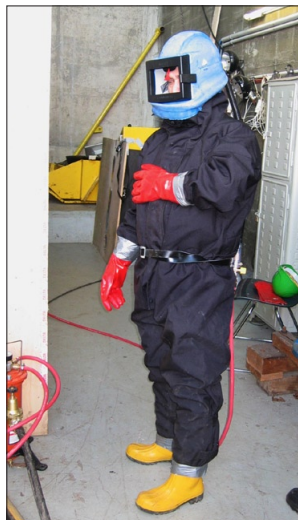
Darbos ar ļoti augstu azbesta šķiedru koncentrāciju, jāizmanto gan aizsargkostīms, gan pilna sejas maska un autonoma gaisa padeve
