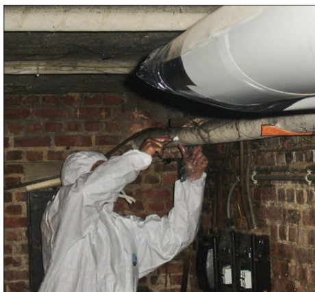
Azbestu saturošu materiālu paraugu paņemšanas laikā arī jāievēro drošības prasības, piemēram, noteikti jālieto elpceļus aizsargājošs respirators
