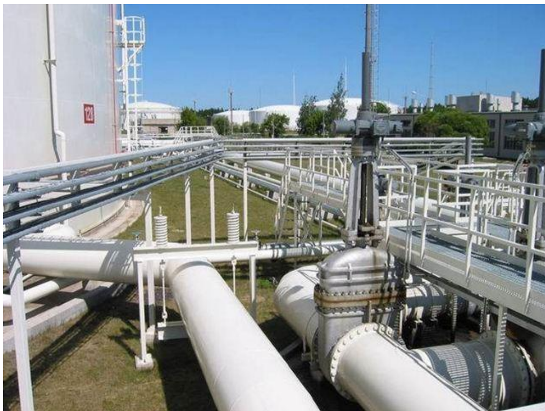
2. PIEMĒRS. Tehniskie un maģistrālie ķīmisko vielu transportēšanas cauruļvadi.
