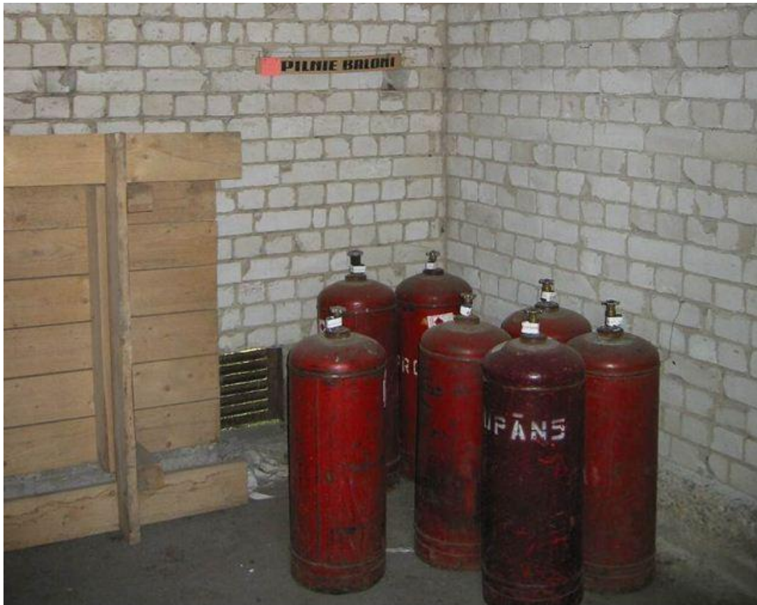
4. PIEMĒRS. Nepiemērota gāzes balonu uzglabāšanas telpas.
