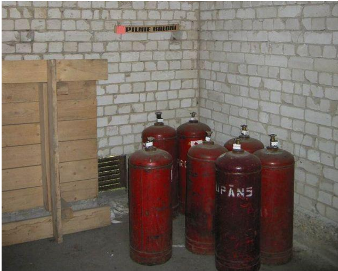
4. PIEMĒRS. Nepiemērota gāzes balonu uzglabāšanas telpas.
