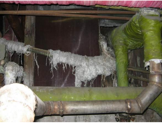
5.attēls. Bojāta azbestu saturoša siltumizolācija
