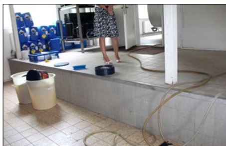
Neapzīmēta, nenorobežota rampas mala, nevietā novietoti cauruļvadi un nepiemēroti apavi rada gan pakļupšanas, gan kritiena risku
