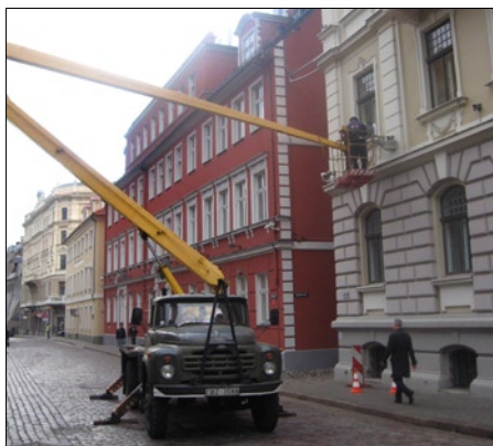
Darbus augstumā no pacēlāja nedrīkst veikt bez bīstamās darba zonas norobežošanas
