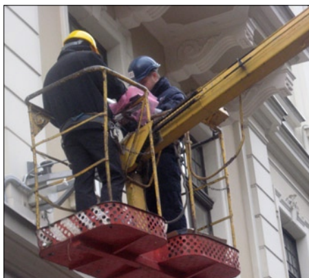
Nav pieļaujama neatbilstošu individuālās aizsardzības līdzekļu (drošības jostas iekares vietā) lietošana
