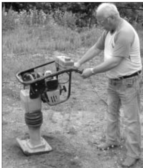
4.3. attēls. Vispārējās un vietējās vibrācijas iedarbība grunts blīvēšanas darbos
