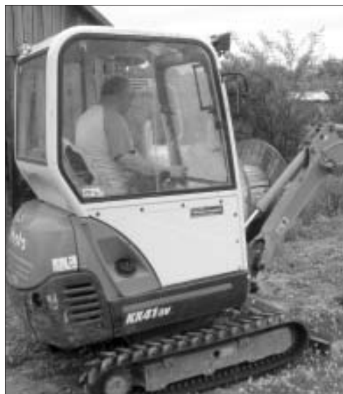
4.2. attēls. Vispārējās un vietējās vibrācijas iedarbība zemes rakšanas darbos ar ekskavatoru
