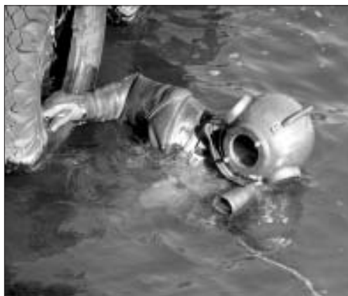
4.11. attēls. Ūdenslīdzis smagajā aprikojumā
